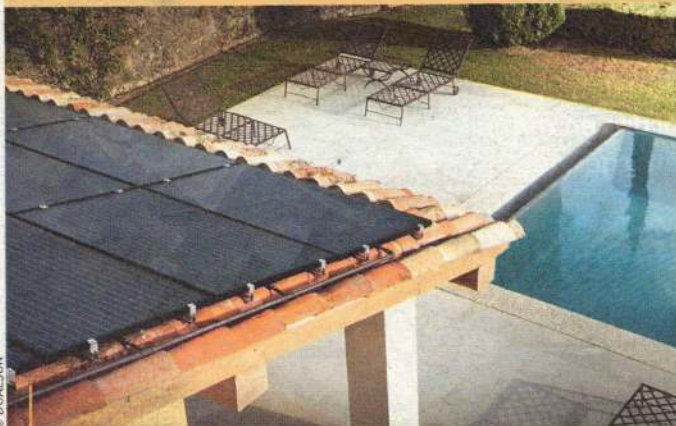
Les panneaux hybrides DualSun permettent de chauffer des piscines (installations municipales ou particulières)
