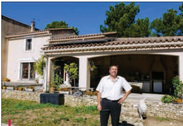
Jean Minet, général manager de la société GREEN EnR a installé sur le toit de sa maison un module hybride conçu par DualSun qui produit de l'électricité et de l'eau chaude.
