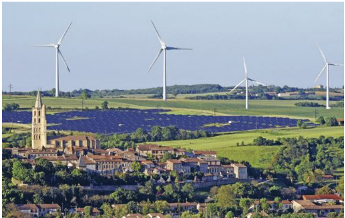
Le parc éolien et photovoltaïque d'Avignonnet-Lauragais, au sud de Toulouse, assure l'alimentation électrique de 5 000 foyers (hors chauffage). © REMY GABALDA / AFP
