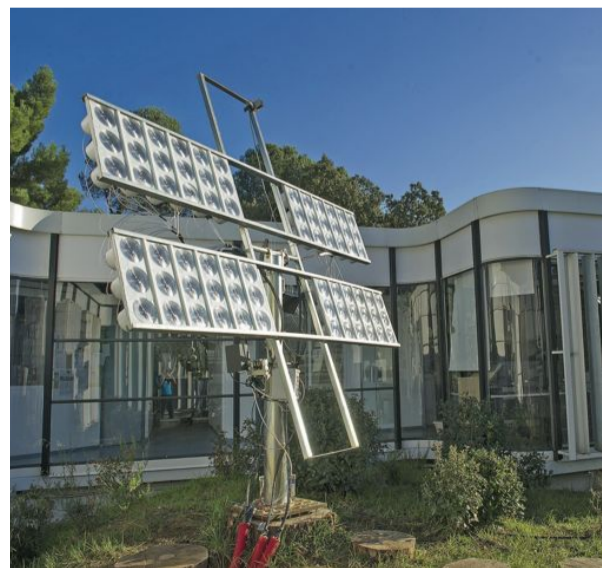
Le panneau de loupes d'Echy concentre la lumière naturelle qui est ensuite transportée par fibre optique. © ECHY
