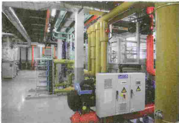
Le site sera chauffé par deux pompes à chaleur, dont l'une à sustentation magnétique.
